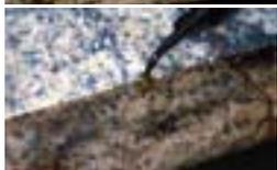
Schadstelle an der Kante mit transparentem Band abkleben. Applikation von **AKELUX** Filler Transparent Liquid oder Transparent Gel zur Erstbefüllung.
