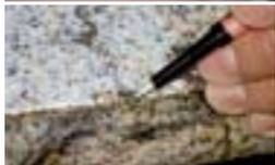
**AKELUX** Primer zur Haftvermittlung auftragen und 60 sec trocknen lassen.
