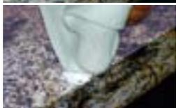
**AKELUX** Polierpaste auf den Stein auftragen. Manuell mit **AKELUX** Poliertuch und der Filzseite des Schleifblocks oder maschinell aufpolieren.
