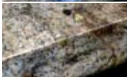
**AKELUX** Transparent Liquid mit **AKELUX** Filler farbig auf Steinfärbung abstimmen. Ggf. mit **AKELUX** Structure füllen und aushärten.
